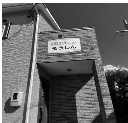
図5 空き家を活用した事業所
